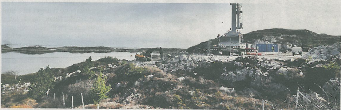
Arbeidet i gang: Anleggsarbeidet er allerede i gang på Kverva på Frøya. Deler av fundamentet skal blant annet skytes inn i berggrunnen under huset, noe som vil gi plass til en underetasje og samtidig gjøre huset mindre ruvende.
